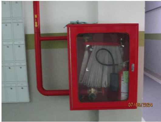
รูปที่ 2.7-2 ตู้เก็บสายฉีดน้ำดับเพลิง
