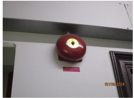
รูปที่ 2.7-3 Fire Alarm Bell
