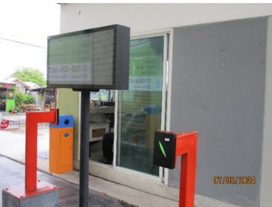
รูปที่ 3-27 ระบบบันทึกปริมาณรถยนต์และรถจักรยานยนต์ ที่เข้าจอดภายในพื้นที่โครงการ
